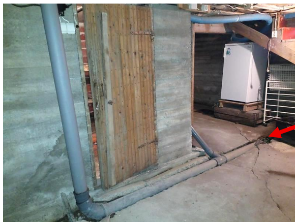
Viemäriliitos epätiivis.
